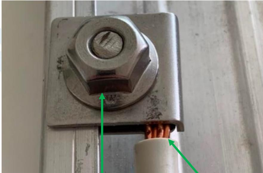
Serrez le boulon avec un couple de 10Nm
